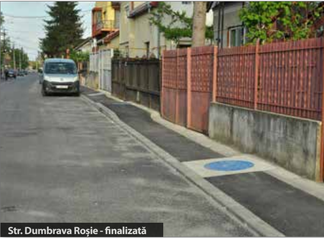
Str. Dumbrava Roșie - finalizată
