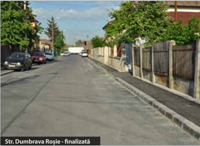
Str. Dumbrava Roșie - finalizată
