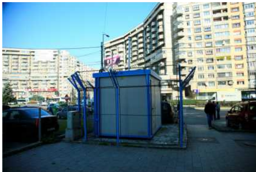
Fig.10 Stație de monitorizare trafic CJ-1 .
